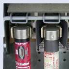
Eléctrica: Fusible sobrecalentado
